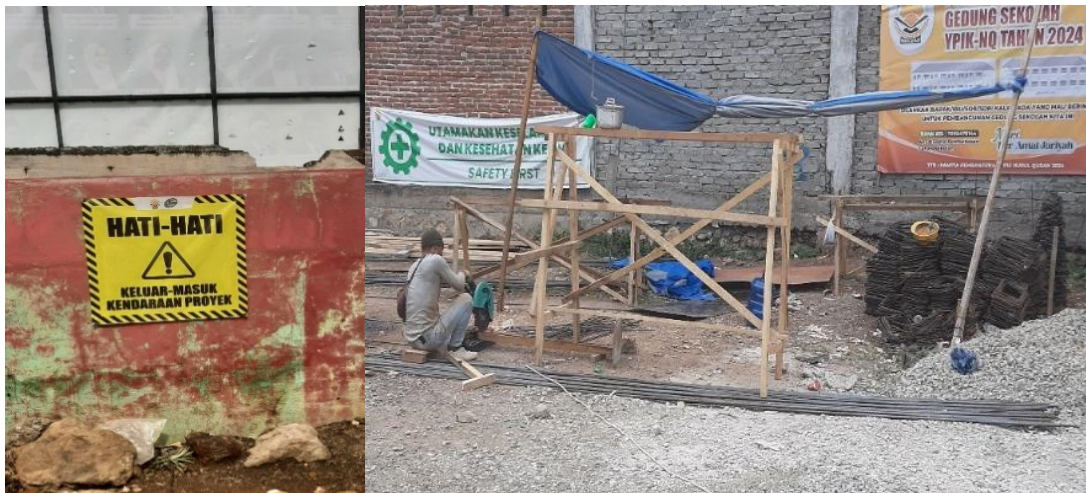
Gambar 2. Pemasangan rambu/tanda K3 pada proyek Kontruksi Gedung sekolah dasar Islam Karakteristik di Kabupaten Aceh Besar
