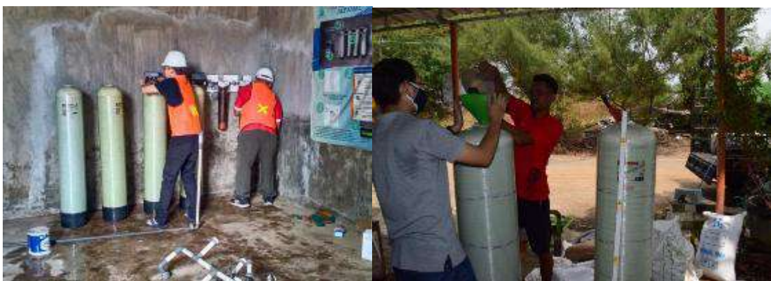
Gambar 4. Pemasangan alat pemurni air
