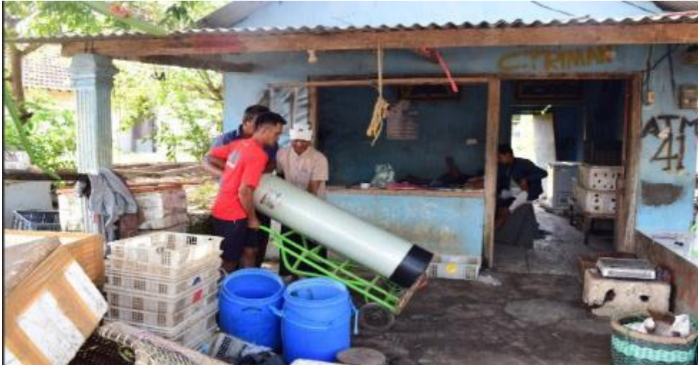
Gambar 2. Pemasangan ALPAMAL pada rumah warga
